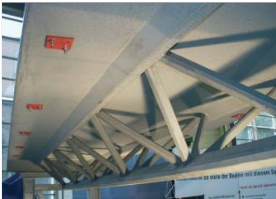
Fig. 23: Parte del puente de hormigón ultra resistente, fabricado por Max Bögl
