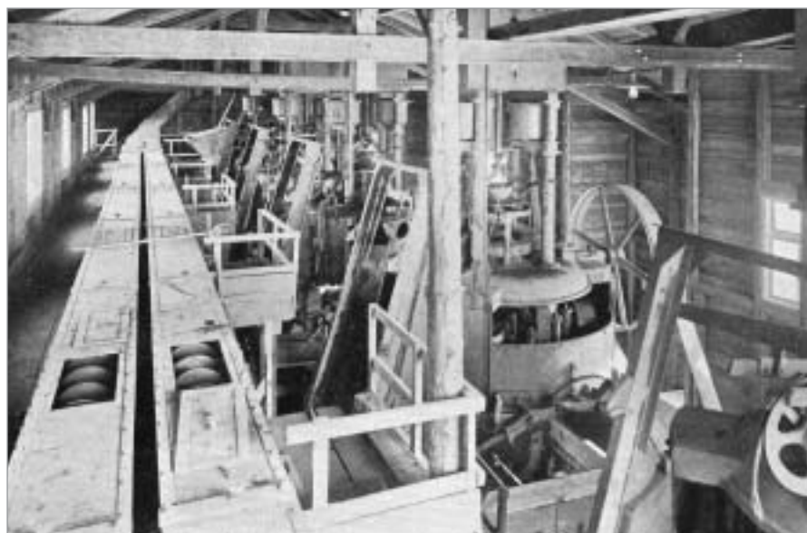
Fig. 9: Estación de mezclado para la construcción del canal del Mar del Norte – Báltico (de 1907 a 1914)
